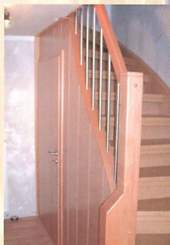
Treppenbeispiel 7 ▼ Komplettrenovierung, Laminatstufen in Buche gedämpft mit Wangenver- kleidung, neuem Geländer, seitlichem Treppenabgang und neuer Tür
