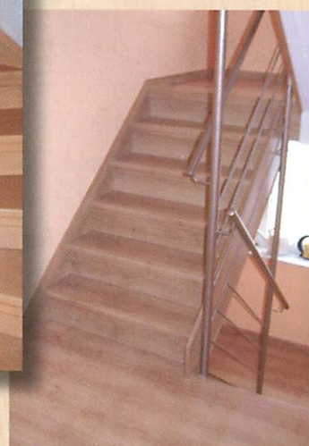
Treppenbeispiel 5 ▲ Laminatstufen in Eiche rutschfest, altes Geländer lackiert in Hammerschlag kupfer
