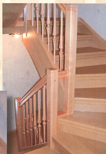
Treppenbeispiel 6 ▲ Laminatstufen in Buche gedämpft mit Wangenverkleidung, neues Geländer mit gedrehten Stäben
