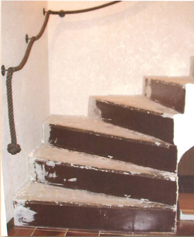
Vorher: Altbelag auf Betontreppe entfernt
